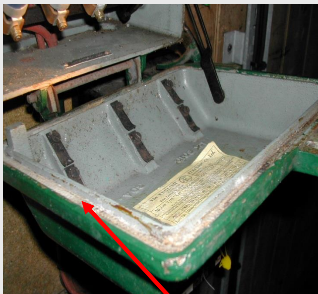
Switchgear Door Seal
