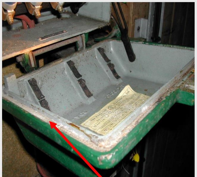
Switchgear Door Seal
